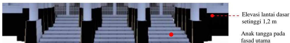
Gambar 14. Elemen Tangga Utama Pada Gedung Merdeka
