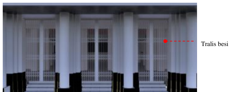
Gambar 12. Bukaan Pintu Utama Gedung Merdeka
