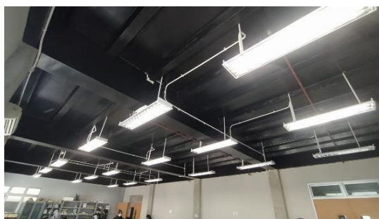
Gambar 11. Plafon Ruang Kelas Studio Gambar 3
