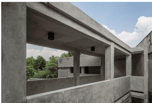
Gambar 7: Ekspos instalasi listrik pada koridor
