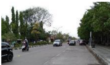
Gambar 20. Preservasi di Koridor Jalan Jalan Cipto Mangunkusumo (sudah baik)
