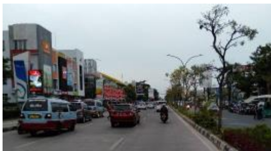
Gambar 14. Ruang terbuka di Koridor Jalan Cipto Mangunkusumo Cirebon (kurang baik) Sumber : Hasil Survei 2019
