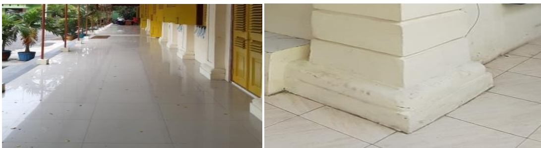
Gambar 3.7. Lantai keramaik pada bangunan SMPN 16 Kota Cirebon Sumber : Hasil survey, 2020
