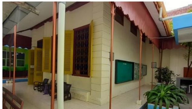
Gambar 3.6. Bentuk Dinding pada bangunan SMPN 16 Kota Cirebon
