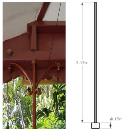
Gambar 3.6. Bentuk Kolom pada teras bangunan SMPN 16 Kota Cirebon
