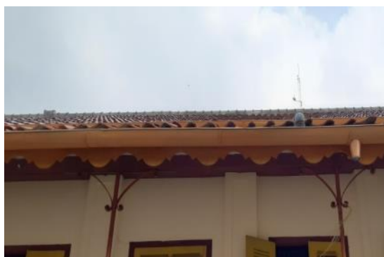
Gambar 3.5. Bentuk ornamen atap pada bangunan SMPN 16 Kota Cirebon
