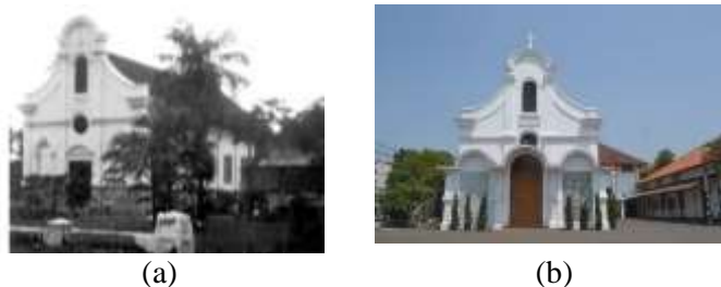
Gambar 1. Kondisi Gereja St. Yusuf Cirebon Tahun 1880 (a), Kondisi Saat Ini Tahun 2020 (b)
