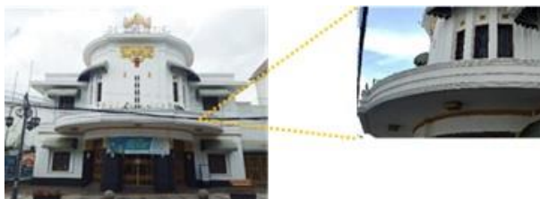
Gambar 15. Tritisan pada Gedung De Majestic
