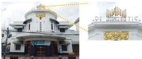
Gambar 19. Tanda-tanda pada Gedung De Majestic
