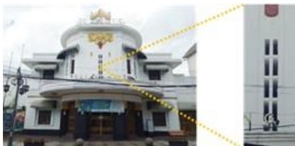
Gambar 10. Ventilasi pada Gedung De Majestic
