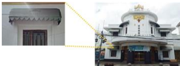
Gambar 17. Awning pada Gedung De Majestic
