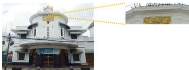
Gambar 20. Balok pada Gedung De Majestic
