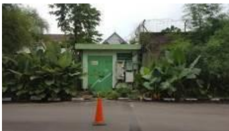
Gambar 23. Ruangan Pemeliharaan PLN (sumber: hasil survey, 2017)
