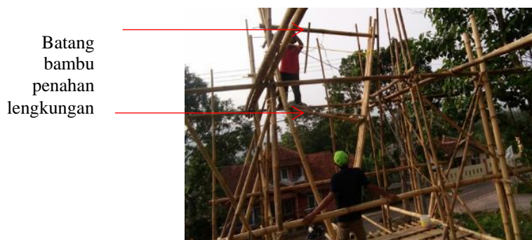
Gambar 16. Pelaksanaan konstruksi Sumber : Himpunan Mahasiswa Arsitektur Itenas
