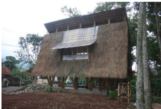
Gambar 19. Bangunan perpustakaan mikro saat selesai konstruksi
