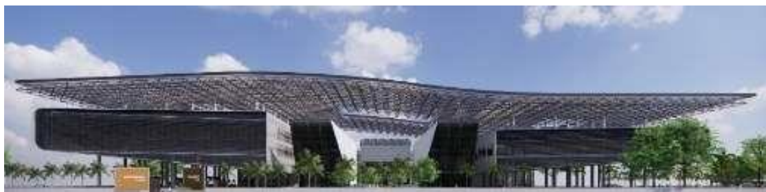
Gambar 17. Hasil Akhir Bangunan Creative Hub
