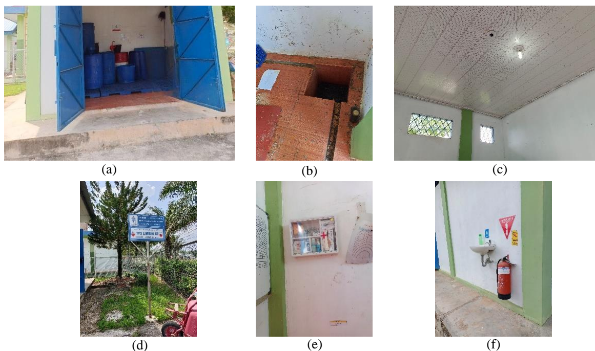
Gambar 1. Kondisi TPS LB3: (a) Posisi TPS LB3 yang Lebih Tinggi dari Area di Sekitarnya, (b) Bak Penampung Tumpahan, (c) Atap, Pendeteksi Kebakaran, Lampu, dan Ventilasi, (d) Tiang Penanda dan Alat Bongkar Muat Barang, (e) APAR dan Wastafel
