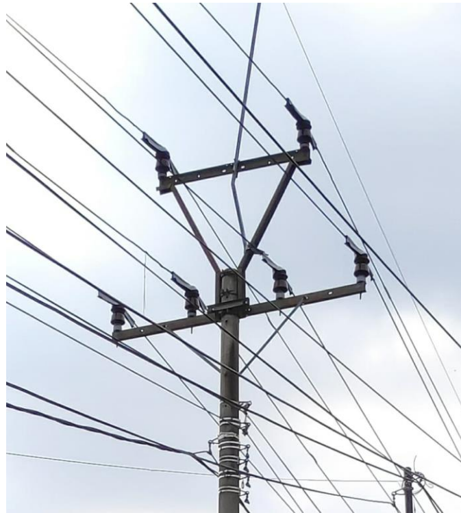
Gambar 7. Foto aktual Kontruksi Double Feeder 3B
