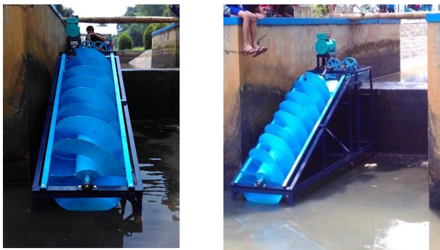
Gambar 9. Proses Pemasangan dan Pengujian Turbin di Lokasi
