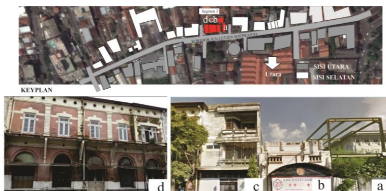
Gambar 12. Visual pada Segmen 3-Sisi Selatan Koridor Terbentuk dari Bangunan (a) Bangunan Baru, (b) Sate Kambing Gulai 29, (c) Hunian-Toko, (d) Gedung Marba
