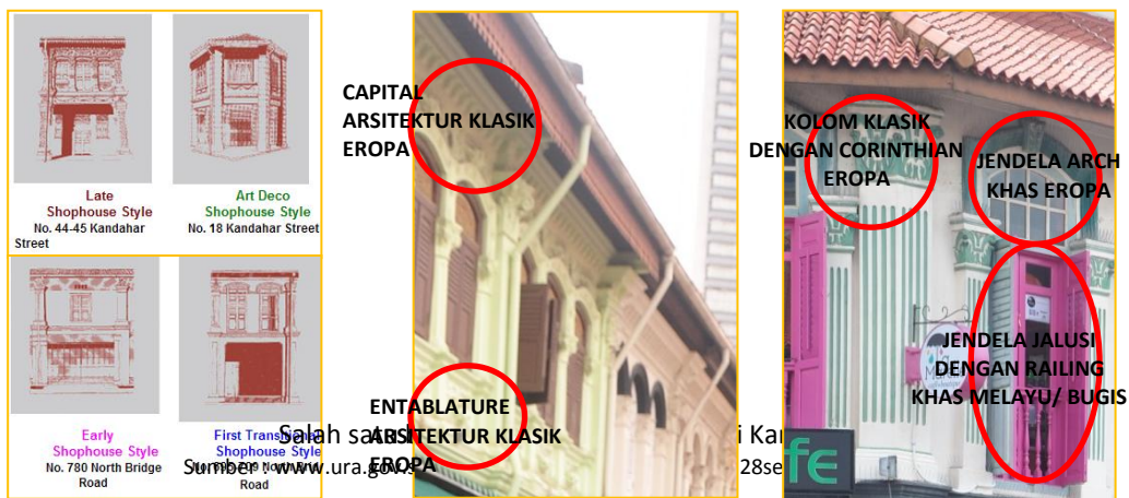
Gambar 13. Salah satu bentuk Tipologi Bangunan di Kampung Glam
