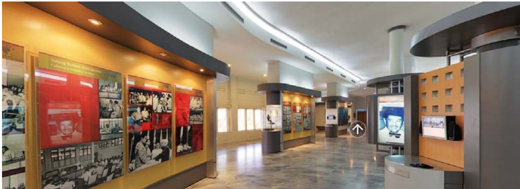
Gambar 25. Penempatan diffuser AC pada drop ceiling Museum KAA
