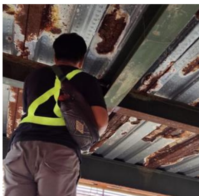
Gambar 7. Kegiatan pengujian Brinell Hardness Test pada pada balok baja di SDN Cipageran Mandiri 1, Kecamatan Cimahi Utara, Kota Cimahi
