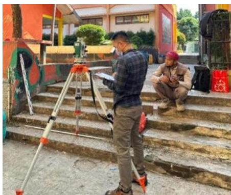
Gambar 4. Kegiatan pengukuran verticality bangunan eksisting pada salah satu kolom menggunakan teodolit di SDN Cipageran Mandiri 1, Kecamatan Cimahi Utara, Kota Cimahi
