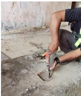
Gambar 6. Kegiatan pengujian Rebound Hammer Test pada pada pelat lantai di SDN Cipageran Mandiri 1, Kecamatan Cimahi Utara, Kota Cimahi
