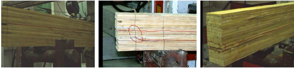
Gambar 4. Keruntuhan pada balok BLP-G [2]
