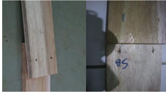
Gambar 6. Kondisi benda uji sekrup kayu Sengon setelah terjadi keruntuhan
