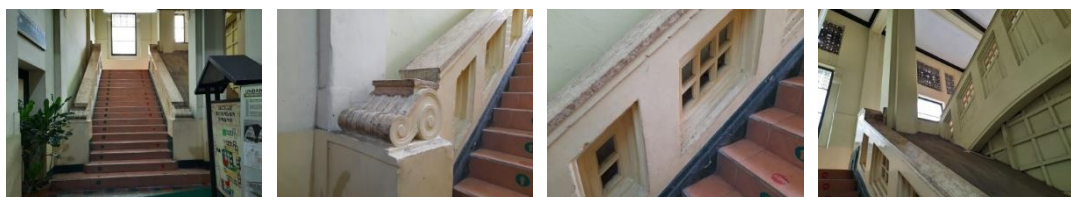
Gambar 25. Tangga dari Lantai 1 Area SMAN 5 Menuju Bordes
