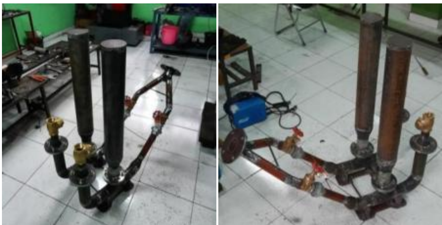
Gambar 8. Kemajuan pembuatan pompa hidram
