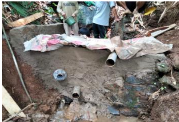
Gambar 10. Bendungan dan saluran keluar air yang telah selesai
