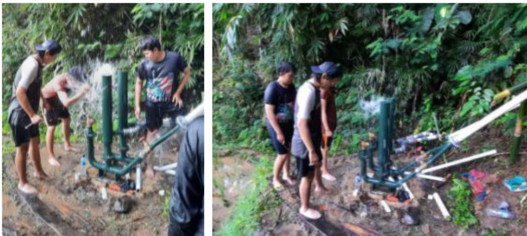
Gambar 12. Uji coba dan penyetelan pompa hidram.
