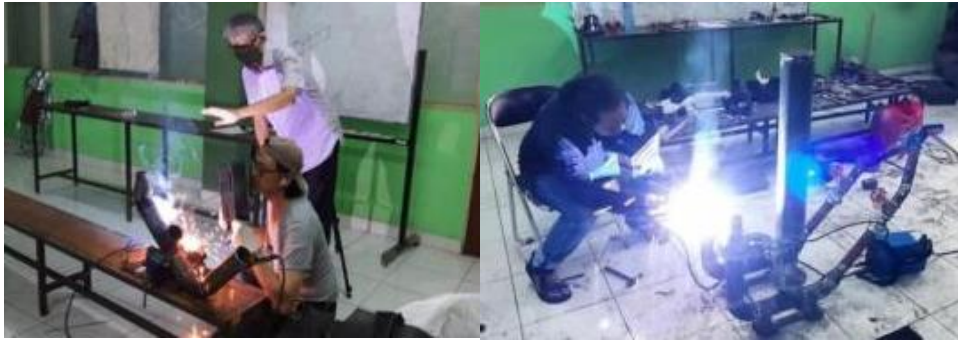
Gambar 6. Proses pengelasan dalam pembuatan pompa hidram
