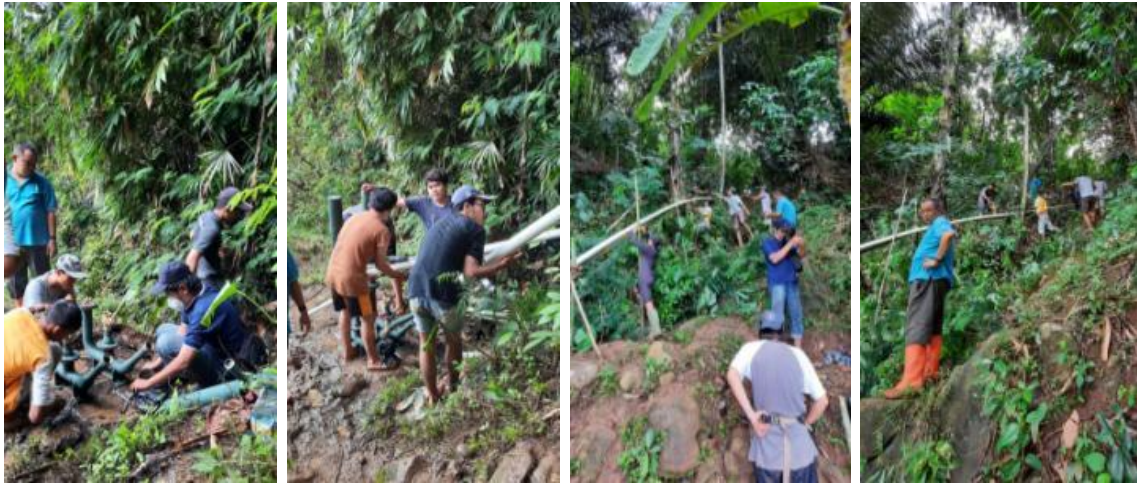
Gambar 11. Pemasangan pompa hidram, saluran air masuk dan keluar.
