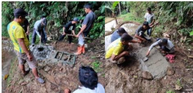
Gambar 9. Pembuatan pondasi dan pemasangan base plate
