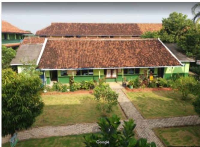
Gambar 1. Situasi Bangunan SMAN 1 Terbanggi Besar (Sumber: Google maps, 2021)
