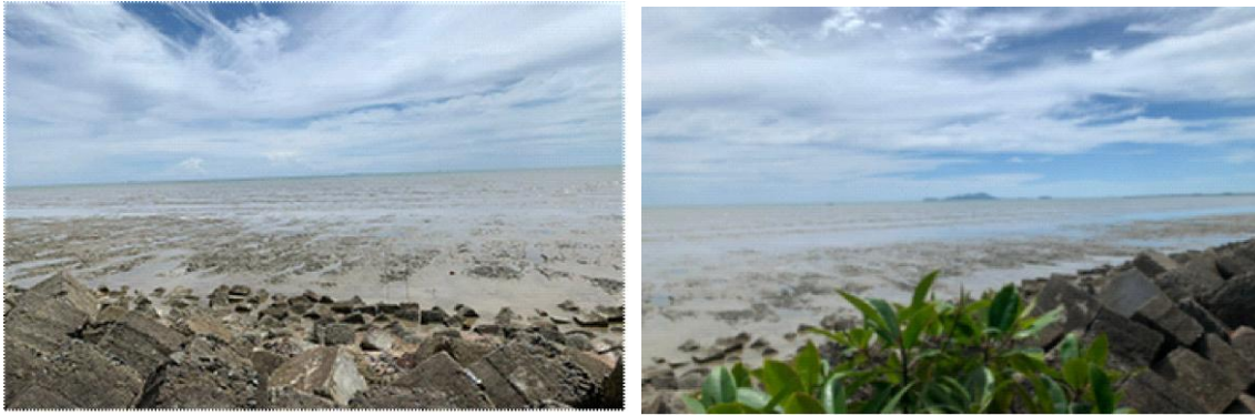
Gambar 1. Pesisir pantai Mempawah yang dilindungi dengan balok-balok beton sebagai pemecah gelombang.
