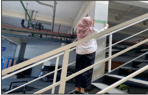
Gambar 6. Pemasangan Display Jalur Evakuasi
