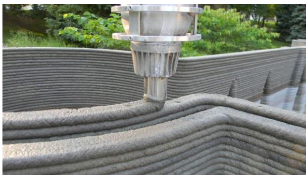
Gambar 1. Proses Pencetakan Produk Arsitektur menggunakan 3D Printer Sumber: Shakir, 2019
