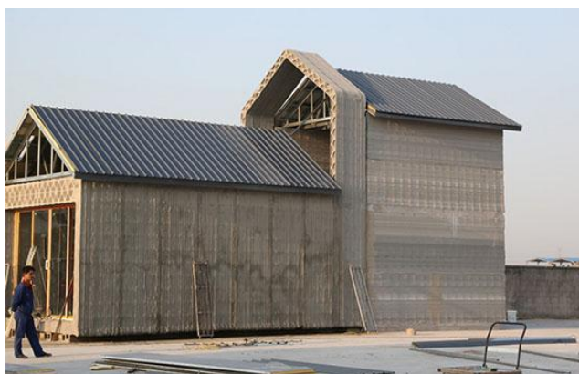
Gambar 2. Pembangunan Rumah Tinggal di China menggunakan Teknologi 3D printing Sumber: Shakir, 2019
