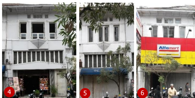
Gambar Bangunan Indo-European di Jalan Braga Bandung
