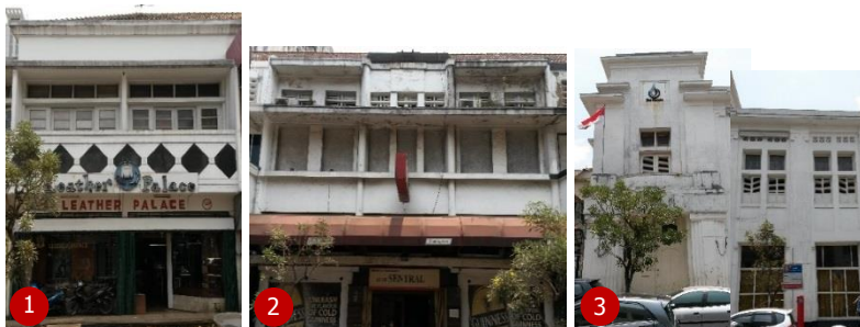
Gambar Bangunan Art Deco di Jalan Braga Bandung
