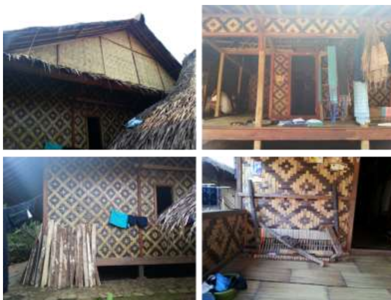
Gambar 10. Bilik kembang pada bangunan Kampung Ciboleger
