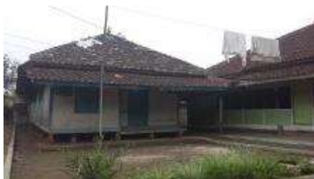
Gbr. 3.4 Kondisi Rumah Di Kampung Mahmud
