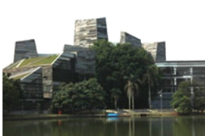
Gbr 1. Fasad bangunan
