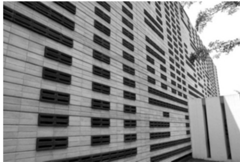
Gambar 5. Fasad Bangunan. (Sumber: Survey Lapangan)
