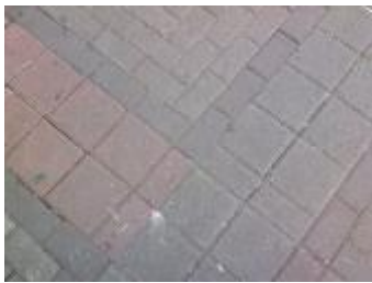
Paving block pola kombinasi.
