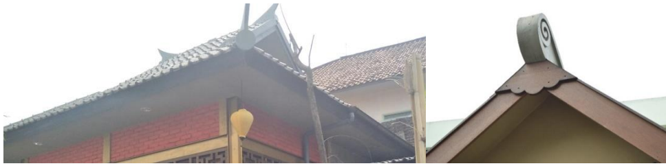
Gambar 3. 7 Detail Atap Bangunan 'Chinatown' Sumber : Foto Survey
