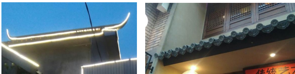
Gambar 3. 8 Detail atap bangunan 'Chinatown' Sumber : Foto Survey
