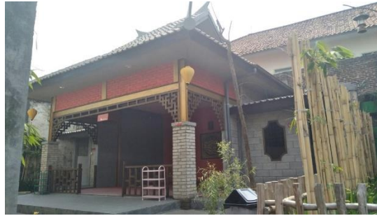
Gambar 3. 14 Mushola Sumber : Foto survey
