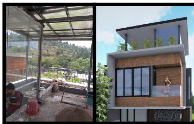
Gambar 1.2. Gambar Pemasangan Tritisan Atap dan 3D Gambar Tritisan SPSM ( Sumber : Data Dokumen dan Lumion 6 )
