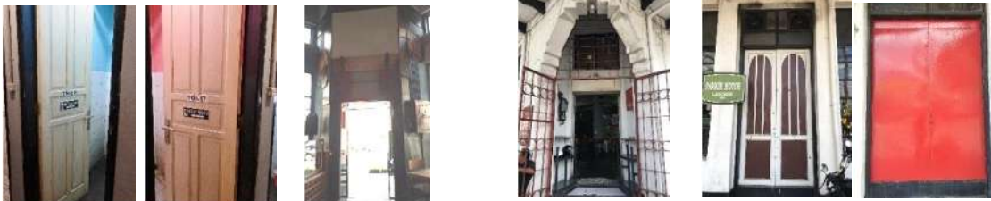
Pintu WC/KM dan pintu dalam Pintu entrance utama dan entrance (Interior)
