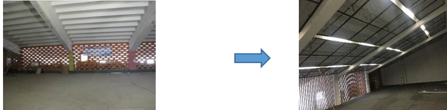
Gambar 3 dan 4. Kondisi D06 sebelum dan setelah perubahan.
