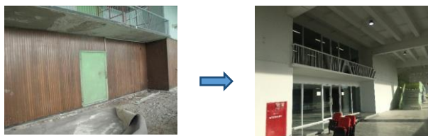
Gambar 9 dan 10. Kondisi D15 sebelum dan setelah perubahan.
