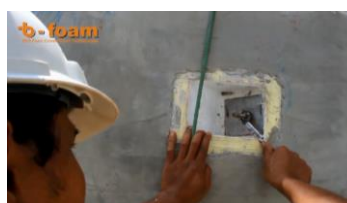
Gambar 32 Pemasngan baut
