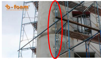
Gambar 33 Lubang untuk angkat
