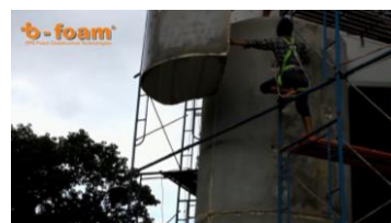
Gambar 29 Proses pemasangan EPS
