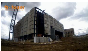
Gambar 22 Proses pemasangan EPS
