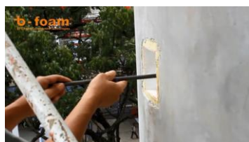
Gambar 31 Pemasangan angkur
