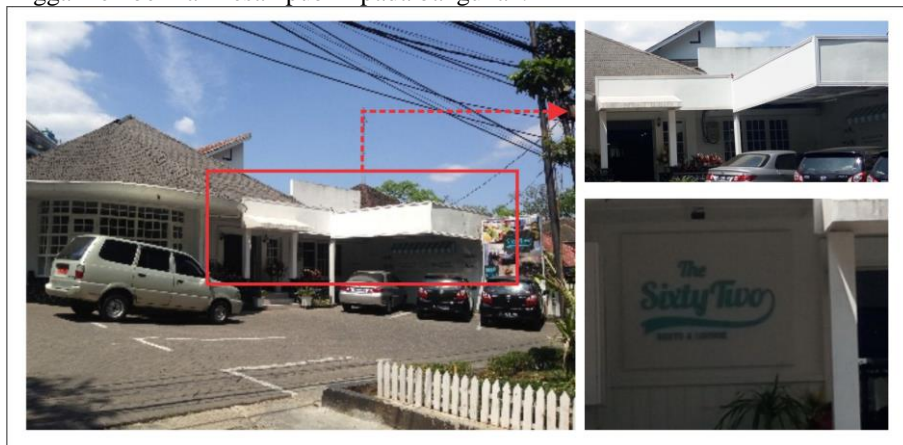
Gambar 8. Bangunan C1 (Sixty Two)
