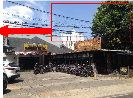
Gambar 4. Bangunan A2 (Sambel Hejo)
