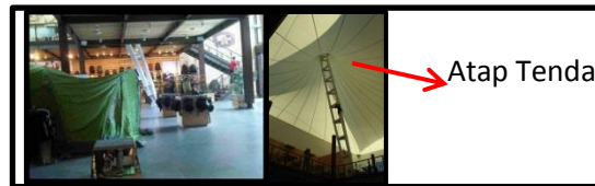
Gambar 20. Elemen Horizontal Atas Pada Interior Bangunan
