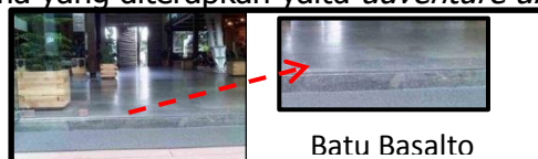
Gambar 19. Material Lantai Pada Interior Bangunan
