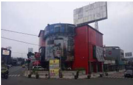
Gambar 12 : Photo bangunan distributor Telkomsel
