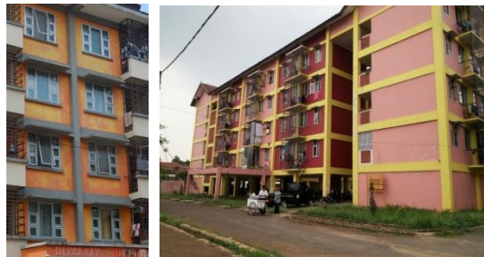
Gambar 1. Kondisi Dinding pada Rusunawa Cingised (Sumber : Survey 22/09/2015 )
