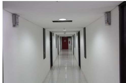
Gambar 4.10 Pintu darurat (sumber : survei lapangan 28 oktober 2015)
