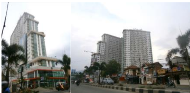
Gambar 2. Kondisi Eksisting Bangunan (Sumber: Dokumentasi Pribadi, 2015)
