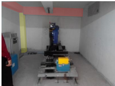
Keterangan: ● Balok ● Kolom Gambar 19. Ruang mesin lift (Sumber: Dokumentasi Pribadi, 2016)
