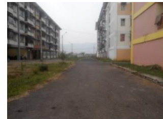
Gambar 3.9 Kondisi Ruang Antar Masa Blok 3 dan Blok 5
