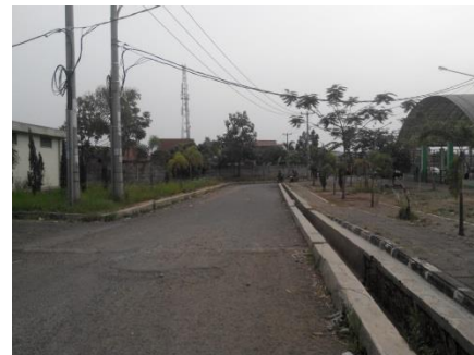
Gambar 3.11 Kondisi Sirkulasi Kendaraan
