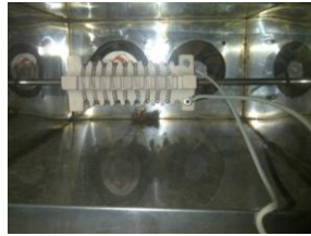
Gambar 10. Pemasangan elemen pemanas dalam box
