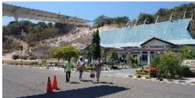
Gambar 3. Bangunan Bandara Mali Alor, 2021.
