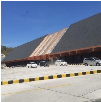
Gambar 2. Bangunan Bandara Mali Alor, 2021.
