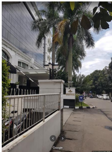
Gambar 1. Pintu Masuk Kendaraan di The Papandayan Hotel.
