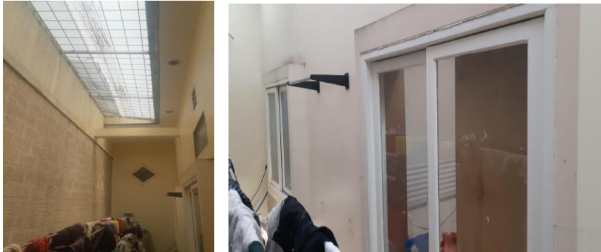
Gambar 1. skylight pada rumah dan Gambar 2 bukaan pada setiap ruangan (jendela) Sumber: Dokumen Pribadi (2022)
