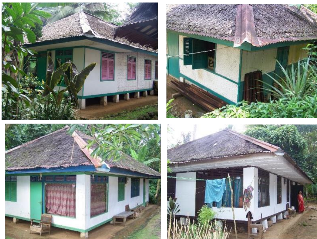
Gambar 8: Atap rumah dengan tambahan material seng pada bagian lereng dan ujung. Sumber: Penulis.
