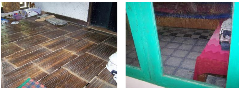
Gambar 9: Lantai bambu yang diratakan (kiri) di beberapa rumah, ditambah lantai vinil. Sumber: Penulis.
