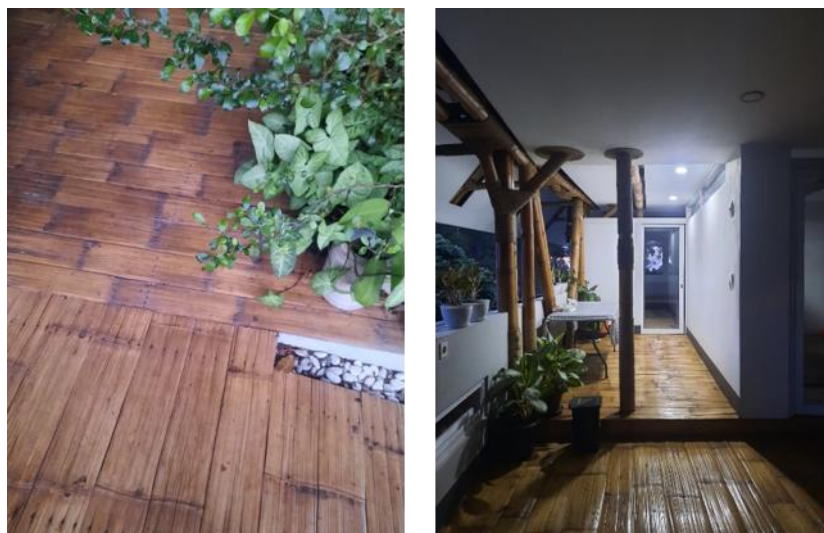
Gambar 8. Penggunaan Bambu Pelupuh sebagai Elemen Permukaan Lantai. Sumber: Najmi 2025
