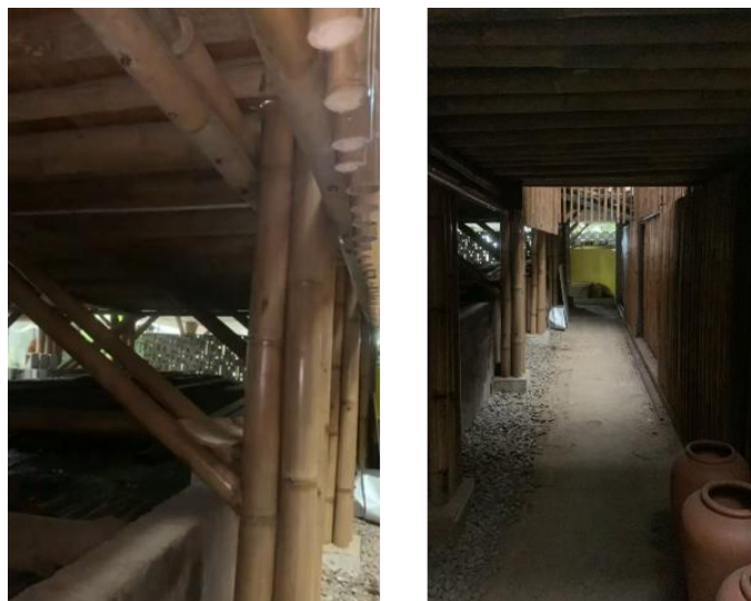
Gambar 6. Penggunaan Beberapa Bambu Petung yang disatukan Sebagai Stuktur Pendukung Utama. Sumber: Najmi 2025
