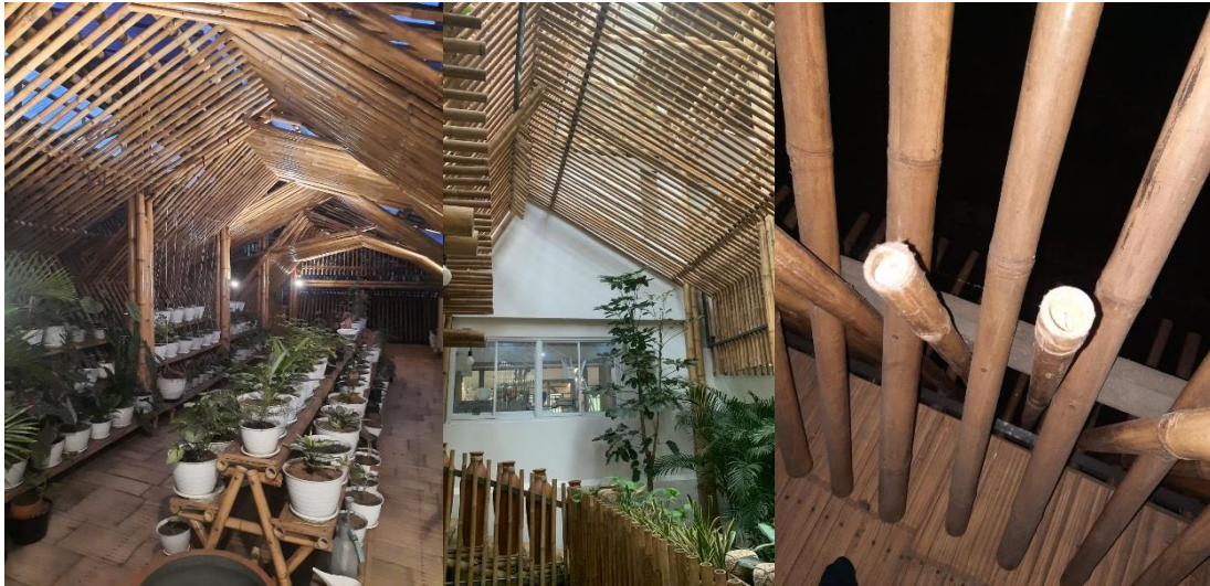
Gambar 2. Penggunaan Bambu Tali sebagai Rangka Atap di Kantor RLA Studio. Sumber: Najmi 2025
