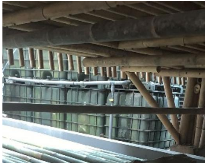
Gambar 7. Penggunaan Beberapa Bambu Petung yang dipasang Berjarak Sebagai Rangka Lantai. Sumber: Najmi 2025
