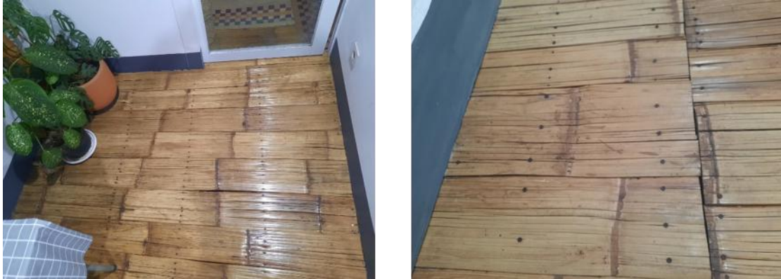
Gambar 5. Penggunaan Bambu Palupuh pada Lantai Kantor RLA Studio. Sumber: Najmi 2025
