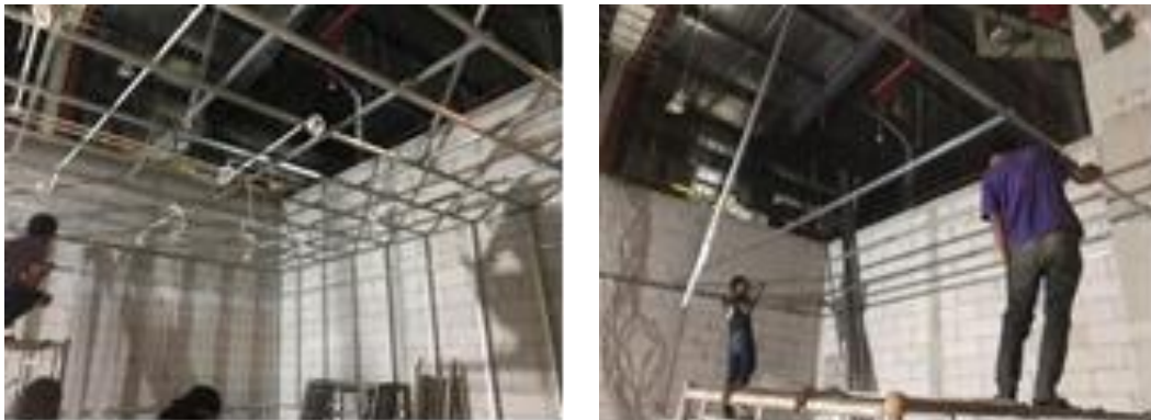
Gambar 18. Pelaksanaan fitting out tenant toko PLAYWORKS (Sumber : Data Pribadi, 2023)
